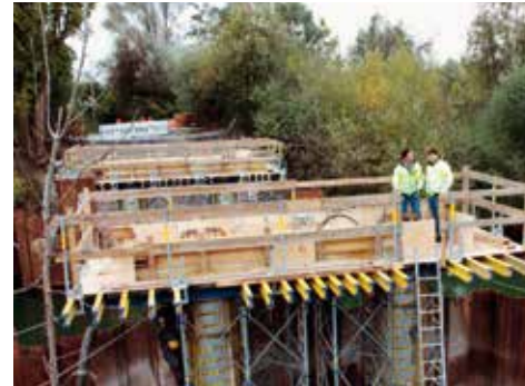
Baustellenüberwachung | Construction site surveillance
