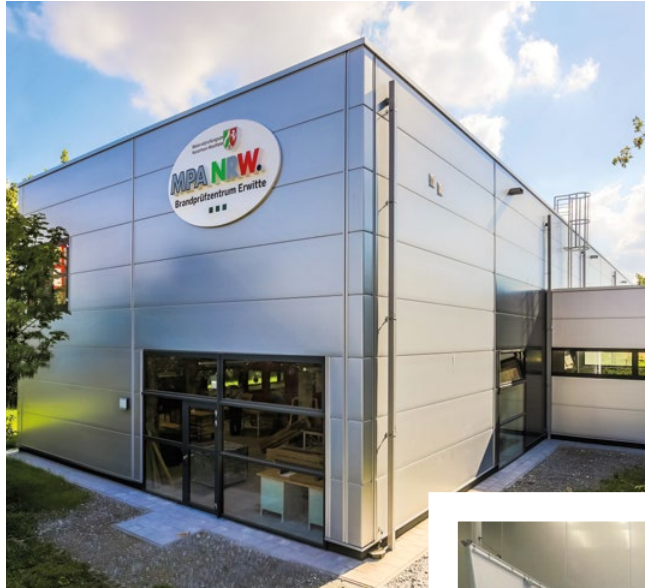
Neue Prüfhalle im Brandprüfzentrum Erwitte.
