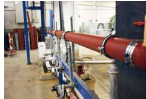
Abwasserrohre mit Spannverbindern | Wastewater pipe with couplings
