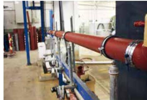
**Abwasserrohre mit Spannverbindern** | Wastewater pipe with couplings
