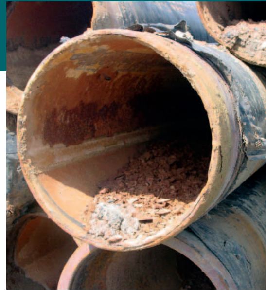
Unbelastet – nur auf den ersten Blick ...
