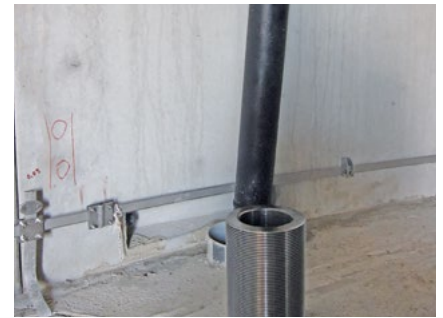
Eine Windkraftanlage entsteht, später von insgesamt 20 Spanngliedern stabilisiert.
