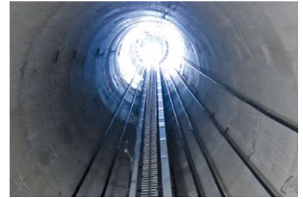
Eine Windkraftanlage entsteht, später von insgesamt 20 Spanngliedern stabilisiert.
