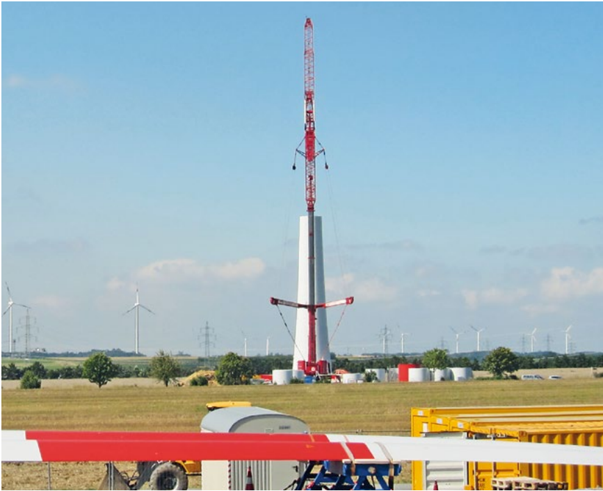
Eine Windkraftanlage entsteht, später von insgesamt 20 Spanngliedern stabilisiert.
