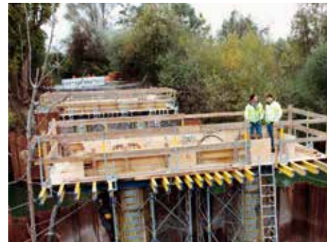
Baustellenüberwachung | Construction site surveillance
