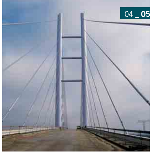
Spektakuläres Brückenbauwerk: Die Ziegelgrabenbrücke bei Stralsund entstand unter Mitwirkung des MPA NRW. Geprüft wurden die Stahlseile im MPA-Labor auf Dauerschwingfestigkeit (Foto unten).
